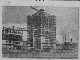
МОСКВА. Строительство высотного здания Московского государственного университета на Ленинских горах. Фото Н. Граванского. Прессбюро ТАСС
