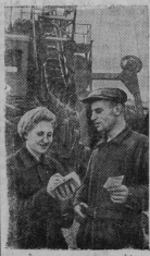
Владимирский. Красноармейский строительный район закончил на своем участке выемку грунта канала. Теперь производится обработка откосов канала и крепление их камнем. На отработке откосов работает многокомовый экскаватор ЭМ-300. На снимке: старший машинист экскаватора В.А. Калачевский вместе с машинистом М.Я. Исаевской, Фотю А. Макаленко.
