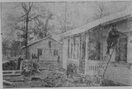
Волынская область. В Кивровской МТС выстроены типовые дома, здание котельной и десять домов для механизаторов.
