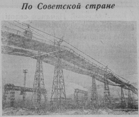
Кубишевский район. Вступила в строй узкоколейная колесная дорога от каменного завода на горе Могучей до бетонного завода. На этом участке по четырем стальным каткам движется более 70 вагонов, которые перевозят 150 тонн щебня в час. На снимке — участок каменной колесной дороги. Пресская ТАСС.
