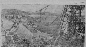
Чехословацкая Республика. В течение первой пятилетки в Словакии построены 125 предприятий. Более 25 заводов значительно расширено и реконструировано. В ряде районов сооружаются гидроэлектростанции. На схеме: плановая Оравская гидроэлектростанция в Словакии. Фото Чехословацкого телеграфного агентства.
