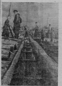
В августе этого года в Урьевском аэропорту принята в эксплуатацию бронекамера протяженностью 450 метров. Она повышает производительность труда на 30 процентов и сокращает расходы на расходы материалов и сырьевые материалы. Фото: В. Симонова.
