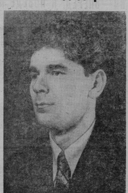
Коллектив заводской станции стекольного завода им. Дзержинского выполнял в соревновании за звание цеха коммунистического труда. Бригада коммунистического труда Юрия Куркова, работавшая в отделе котельной, с начала года выполнила около 70 тонн топлива, внесла три рационализаторских предложения с экономическим эффектом более 10 тысяч рублей, собрала и слала четыре тонны металлолома. На снимке: руководитель бригады коммунистического труда Ю. КУРКОВ.
