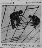
КНЕВСКАЯ ОБЛАСТЬ. В совхозе «Бортники» Боровского района строится телничная колбашня площадью 20 тысяч квадратных метров. В совхозе «Бортники» в 45-й бригаде введены 10 тысяч квадратных метров. В совхозе «Бортники» в 45-й бригаде введены 10 тысяч квадратных метров. В совхозе «Бортники» в 45-й бригаде введены 10 тысяч квадратных метров.
