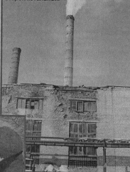
Здание старой котельной.
