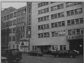
Какое сейчас на хрустальном заводе.
