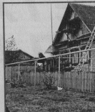
Газопровод на земле
