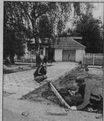
Заканчивается благоустройство участка ул. Октябрьской от ветхой поликарпиды до ул. Калинина. Тротуар выложен плиткой. Обустроены газоны. Единственным недостатком является, наверное, то, что газоны с наклоном в сторону проулочка. Наверняка в следующем году будет заливаться пешеходная дорожка и разрушать плитку.
