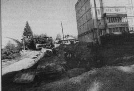
Ремонт теплотрассы у д. № 8 по ул. Коммунистической.
