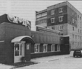
— Здание многофункционального центра на ул. Владимирской.
