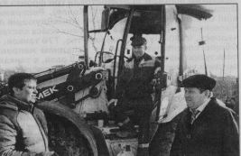
В. Кабаев, А. Шкредов и оператор экскаватора Г. Ульинов на строительной площадке модульной котельной.
