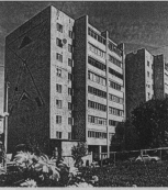
В доме №4 по Тепличному проспекту капитально ремонтируют кровлю.
