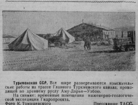
Строители СССР. Все шире разрабатываются изыскательские работы на трассе Главного Туркменского канала, проходящей по Арению русу Амур-Яран-Узюбо.
