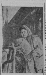
Велгодонстрой. На строительстве Цимлянской гидроузла работает электросварщик Август Ивановна Сергиенко. На снимке: электросварщик А. И. Сергиенко сваривает арматуру основания Цимлянской ГЭС.
