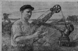
Кубышкинградстрой. Ширится район Стахановского цеха механизации Лужевского строительного района. Прямую изоляцию механизмов, экскаваторов на мески в месяц производят задания на рытье котлована под здание гидроэлектростанции.
