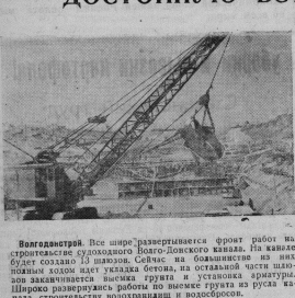
Волгодонск. Все шире раздвигается фронт работ на строительстве судостроительного Волгодонского завода. На каменном холме идет укладка бетона, на остальных частях шлово заканчивается выкладка грунта и установка арматуры. Широко размиряются работы по выемке грунта из русла каменного, строительству водохранилища и водосброса.
