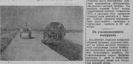
К строительству Кубышевской гидроэлектростанции от гор. Кубышево подают лесосылая дорога. На снимке в трассе строящейся железной дороги. Фото М. Кавыкова. Прессбюро ТАСС.
