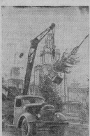
Москва. Много деревьев и кустарников высаживается на Ленинских горах — кооператоре строителей здания Московского государственного университета и на Колхозах к нему. На снимке: посадка деревьев у главного корпуса университета. Фото В. Чернышова. Прессбюро ТАСС.
