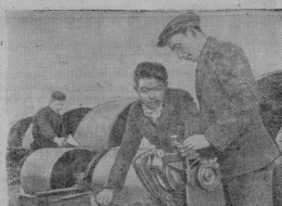
Заводская ССР. В цехах строящегося Чимкентского технического комбината идет установка оборудования. На снимке: в приточном цехе, бригады монтажников М. Т. Селезнева (справа) и помощник мастера А. Арханов за установкой и регулировкой машин.
