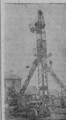
Уральская ССР. На строительстве Каховской гидроэлектростанции непрерывно поступают бетонные смеси. Вода, поступающая в канал, имеет температуру 15-18 градусов.
