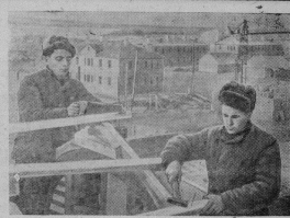
В новой Кожанке широкие фронтоны влет строительства жилых домов и культурно-бытовых учреждений. Хорошо работает комсомольская бригада плотников Андрей Бекан. Сперва вывез за добротное выполнение годового плана, она выработается за смену до двух пор.
