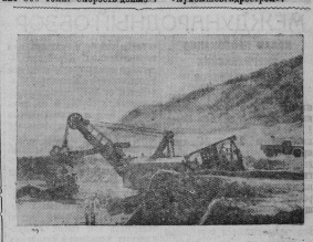
Куйбышевгидрострой. Все шире развертываются работы по строительству дамбы гидростроения. В строй вступают новые машины и механизмы.
