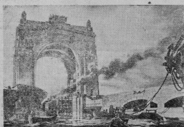
Архитектура обрешетки Волго-Донского канала.
