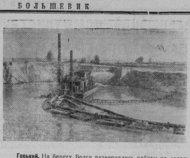
Горный. На берегу Волги развернулись работы по соору- жению гидроэлектростанции. Коллектив строителей работает с большим воодушевлением. Перезод козловско-мозель- ской железной дороги № 18, намытая плотину, значи- тельно перемещают вниз. На снимке: земснаряд № 18 намыкает плотину. Фото П. Волосенского. Прессфото ТАСС.
