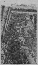
Киевская область. На двух шахтах Кутаиса — Тигранские угли и «Полесневская Северная» — применяется торфяная гидравлическая добыча угля. Опыт показал, что производительность труда при этом способе увеличивается в 4—5 раз. На снимке: гидромониторщик фомоселект И. Н. Колдов, выполняющий работу на 120—130 процентов, за гидравлической отбойкой угля в очистном забое. Фото П. Лисенкина.
