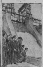
Восточно-Казахстанская область. Группа студентов вузов и техникумов Северо-Восточного Китая, находящаяся на практике в Советском Союзе, посетила Усть-Каменогорскую ГЭС. На снимке: группа китайских студентов у водосливной части плотины Усть-Каменогорской ГЭС.
