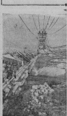
Старовал. Перекрытие русла Волги в районе строительства Куйбышевской ГЭС. Фотография ТАСС
