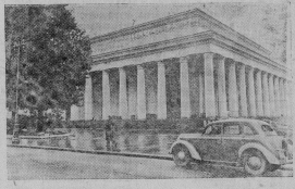
В Ленинграде заканчивается строительство первой очереди метрополитана. Служащий участка подземной магистрали протяженностью 10,8 километра начинается на юго-западной окраине города, в Автово, проходит мимо Кировского завода, Балтийского, Парнасского Витебского вокзалов и завершается на площади Стачек — у Московского вокзала. На переднем плане — стальной, готовый тоннельный сооружение, идет монтаж и испытание экскаваторов и другого оборудования. На снимке: общий вид наземного лановала станции „Кировский завод“.
