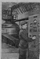
Застежков ГСР. Коллектив строителей Нарской ГЭС соревнуется за достойную встречу XX съезда КПСС, осекая большую трудную победу — победу над промышленную нагрузку грейтер, последний агрегат. Нарская ГЭС поновое вошла в строй — действующая гидроэлектростанция страны.
