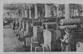
Воршилагград. Коллектив токусковской фабрики имени Ворошилова успешно осваивает новое оборудование отечественного производства. В преддверии пект установлены новые комби-прядильные машины непрерывного действия. Их производительность в полтора раза превышает старые, ранее применявшиеся здесь.
