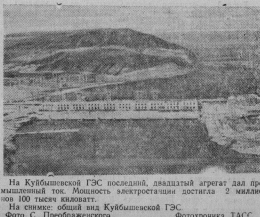
На Кубышевской ГЭС последний, двенадцатый агрегат для промышленности тол. Мощность электростанции достигла 2 миллионов 100 тысяч киловатт.
