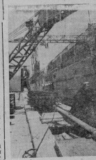
Строительство Воронежской атомной электростанции. Много трудящихся.
