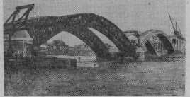
Продолжается строительство автодорожного моста через Волгу в городе Рыбинске. Фото А. Скорина.
