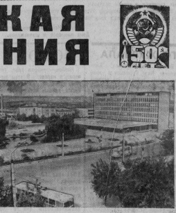
Стенды Туркменской ССР—Ашхабад. Площадь имени Юрия Маркса. На переднем плане — новые семитонные здания управления «Каркумстрой».
