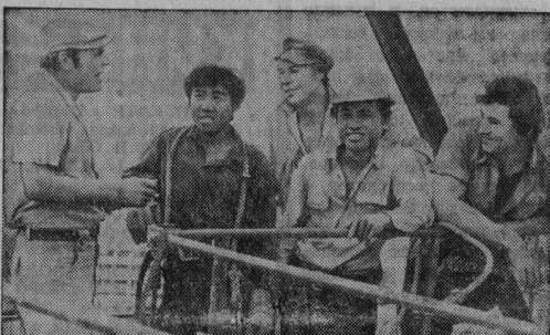
Во Вьетнаме силами строителей двух братских стран ЛНДР и СССР завершено сооружение башни радиорелейной линии космической станции «Интерспутник». НА СНИМКЕ: группа советских и лаосских строителей, принимавших участие в сооружении башни. Фото А. Ерошечкова (Фотохроника ТАСС).
