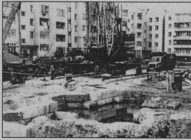
■ На строительной площадке дома МКХ работа идет полным ходом.
