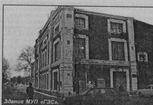
Здание МУП «ГЭС».
