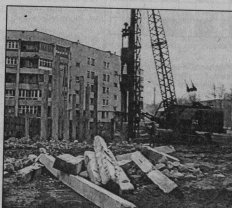
АО «Стелстрой» закладывает новый дом.
